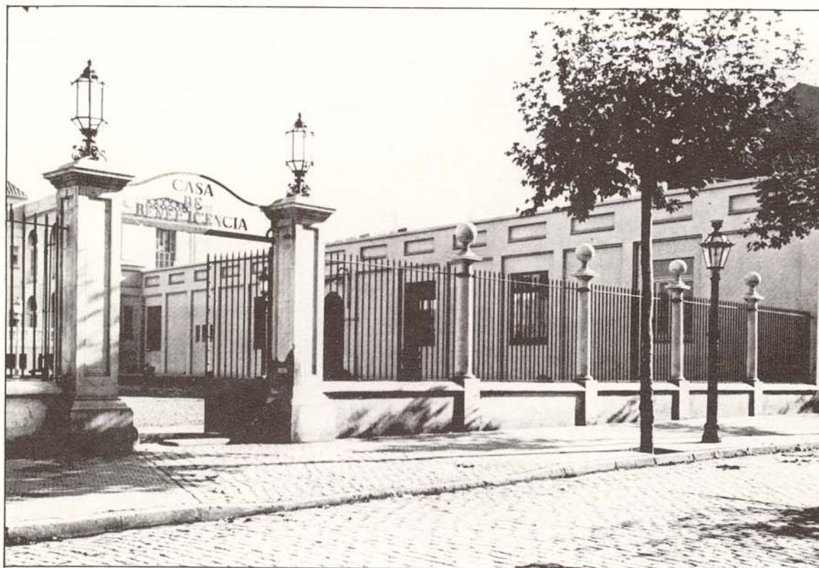
Casa Caritat, 1928. Façana Via Massagué.
