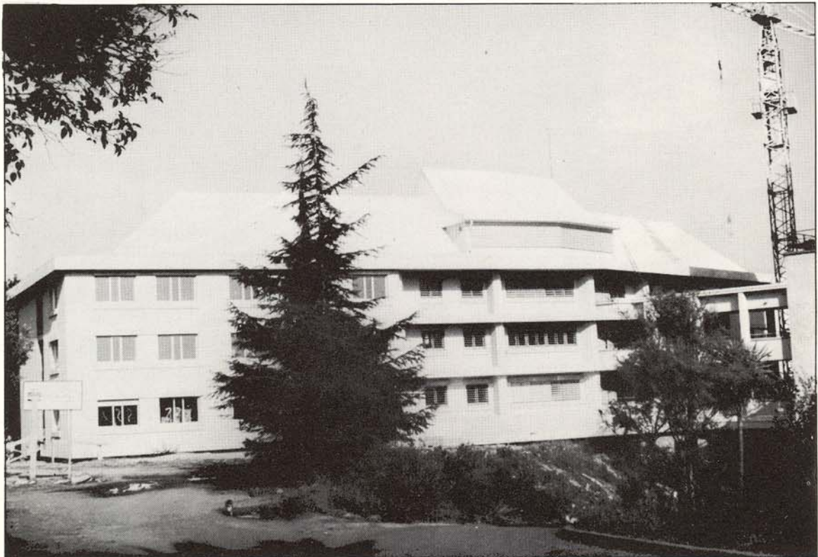
Pavelló VII Centenari, en construcció.
